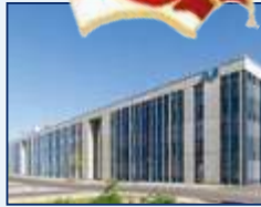
Erweiterungsbauten Hochschule Bonn-Rhein-Sieg Tragwerksplanung, Bauphysik, Brandschutz Foto: hmp ARCHITEKTEN
