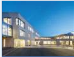
Bonns Fünfte – Ausbau Gesamtschule Bonn Brandschutz, Prüfstatik, Instandhaltung Foto: JÜRGEN SCHMIDT
