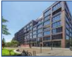
I/D Cologne, Schanzenstraße Bauphysik, Prüfstatik Foto: RALPH RICHTER
